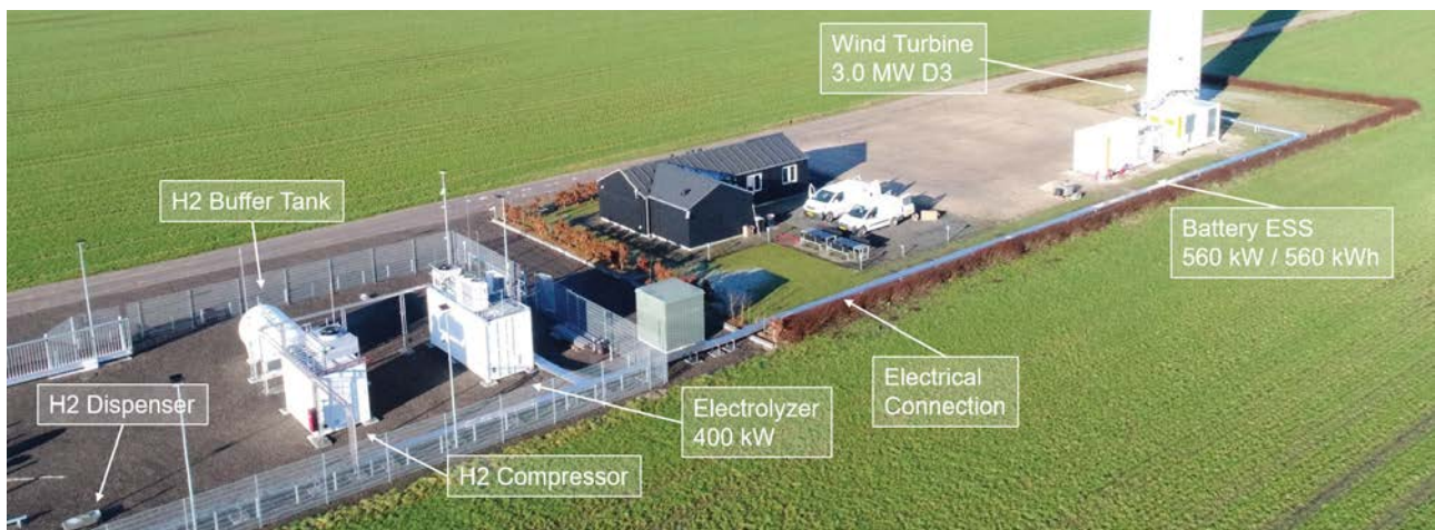
Figur 6. Siemens Gamesa hydrogen pilot plant i Brande. Power-to-X anlægget blev besøgt af Udvalget for bæredygtig energi fra Ærø i august 2022. Kilde: Siemens Gamesa Green hydrogen unlocked, the Brande hydrogen project white paper, September 2022.
